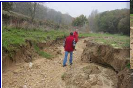
(Source : SMBVVG) Ravinement et destruction du chemin de la Croix Rouge (2012)
