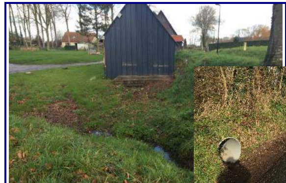
...Seul exutoire possible : une bétière s carrefour
