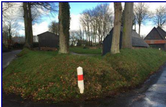
Inondation de voirie au niveau du carrefour entre la route de Limerville et la route des Tourterelles...
