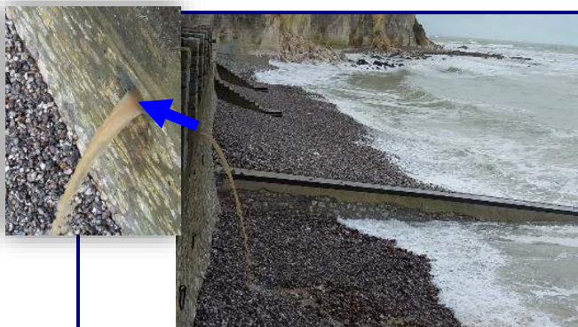
Rejet pluvial sur la plage des Grandes Dalles (Janvier 2016)
