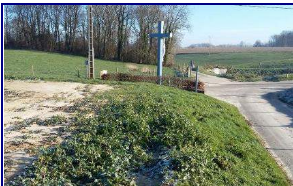
Les pluies provoquent un dépôt de limons sur le carrefour entre la route de Saint Pierre et la rue de la Mairie avant de rejoindre le bassin de
