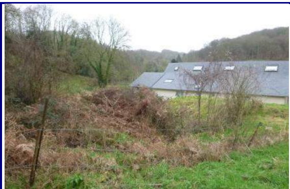
Talus de protection créé suite aux inondations des propriétés en aval d'une cavée
