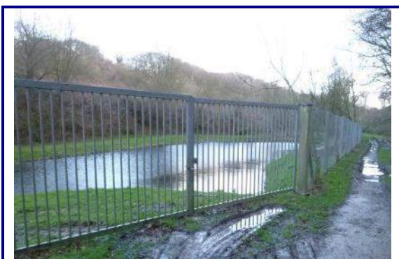
Lors de fortes pluies, le bassin de la station d'épuration déborde. Les apports de ruissellements concentrés sur le chemin d'accès à la STEP contribuent à ce dysfonctionnement. On notera la présence de petits merlons de protection.
