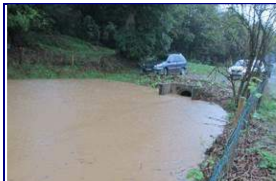
Mise en charge de l'ouvrage de régulation (octobre 2013). L'ouvrage a depuis été équipé d'un barreaudage de protection
