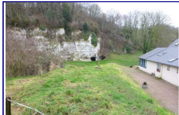
Le talus détourne les eaux vers la rue de la Porte des Champs par les jardins de ces propriétés
