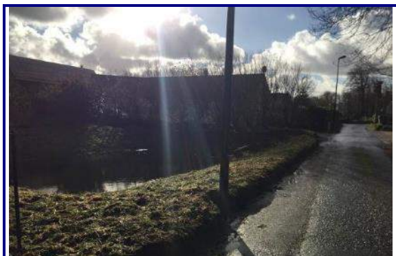
Création d'une mare permettant de limiter les apports vers les habitations en aval immédiat
