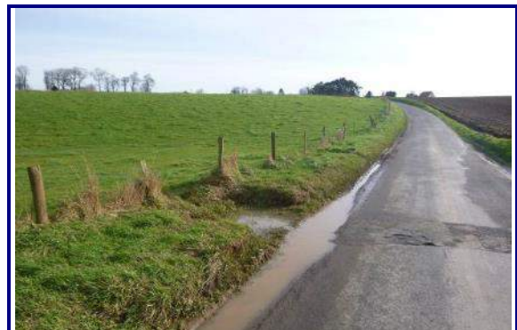
En aval de la Mare Cornu, les écoulements chargés de limons inondent la voirie. L'ouvrage de traversée (en siphon) ne permet pas de gérer l'importance des ruissellements et s'encombre rapidement.
