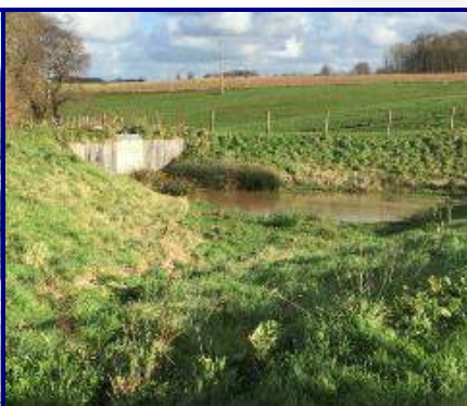
Ouvrages de régulation avec débit de fuite dirigé vers un fossé
