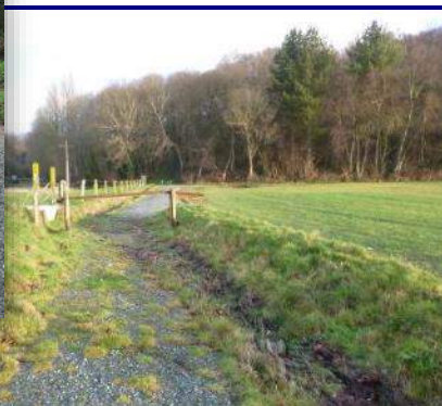
Le chemin, réhabilité depuis, présente des stigmates d'érosion (en médaillon : vue par temps de pluie (SMBVVG) où le busage déborde)
